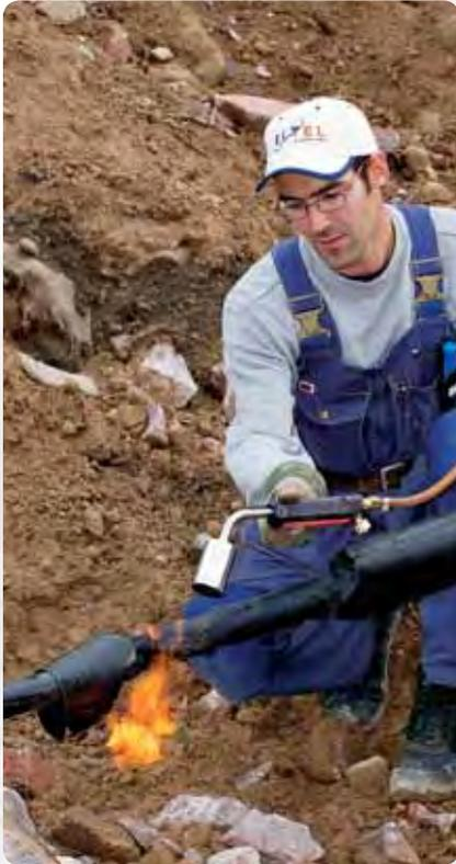
Propanwerkzeuge im Allgemeinen sind bei Handwerkern sehr verbreitet. Sei es zum Hart- und Weichlöten von Rohren und Blechen, zum Erwärmen von Schrumpfmuffen im Kabel- und Leitungsbau, zum Verschweißen von bituminösen Dach- und Dichtungsbahnen oder einfach nur zum Erwärmen.
